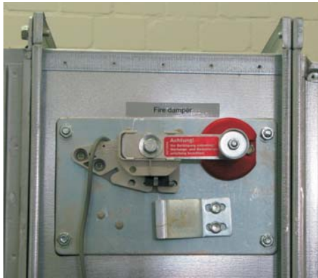
Fig. 2.18 Fire damper
